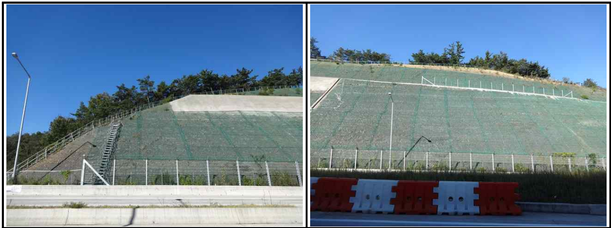
【그림 61.3.4】 보호/보강시설 전경
