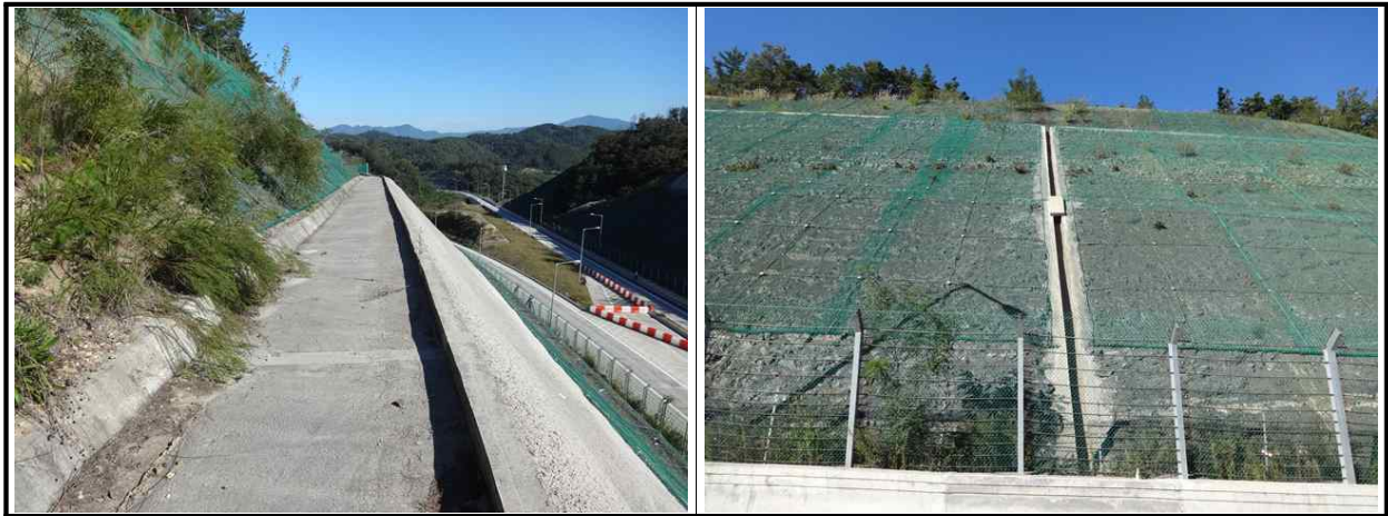
【그림 61.3.3】 배수시설 전경
